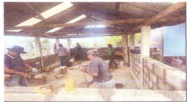
Foto 4: Reparación de cocina
