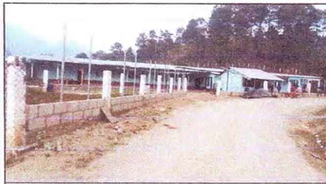
Foto 3: En el proceso del muro perimetral.
