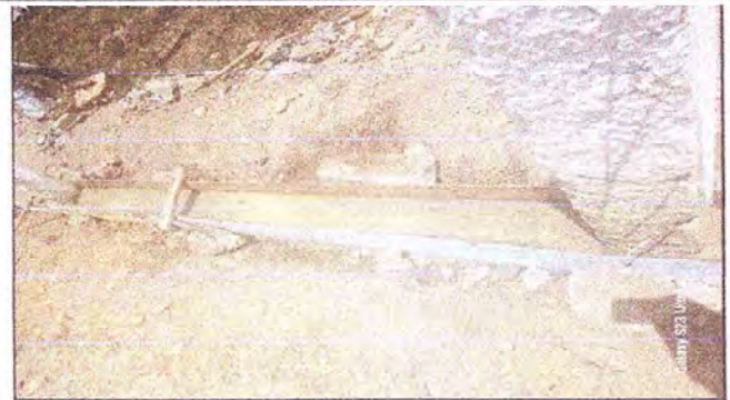
Foto 2: Cimiento para el muro.
