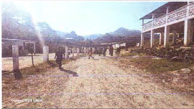
Foto 1: Levantando el muro perimetral.
