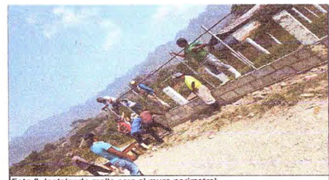
Foto 6: instalando malla para el muro perimetral.
